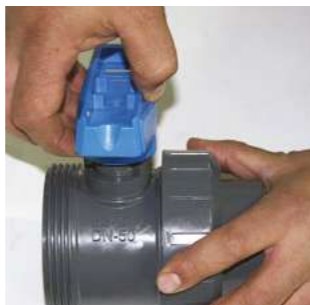
Kol çekilerek çıkartılır ve vanadan ayrılır.
